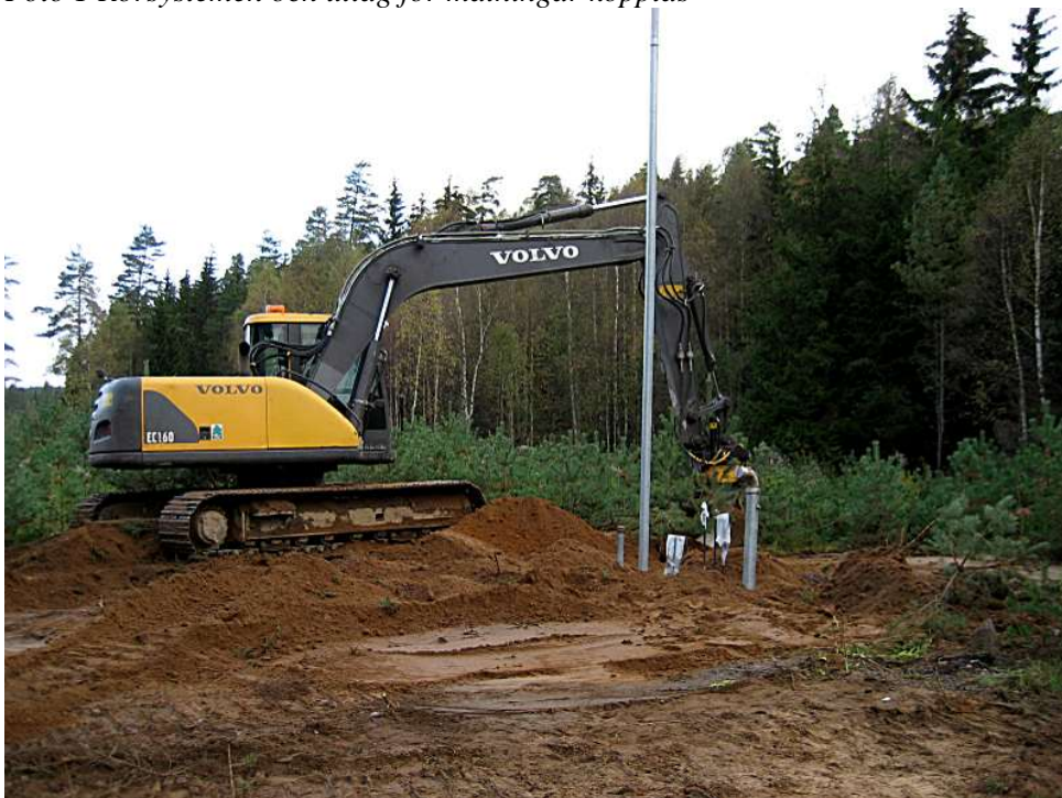
Foto 2 Återfyllnaden runt cisternen nästan klar
